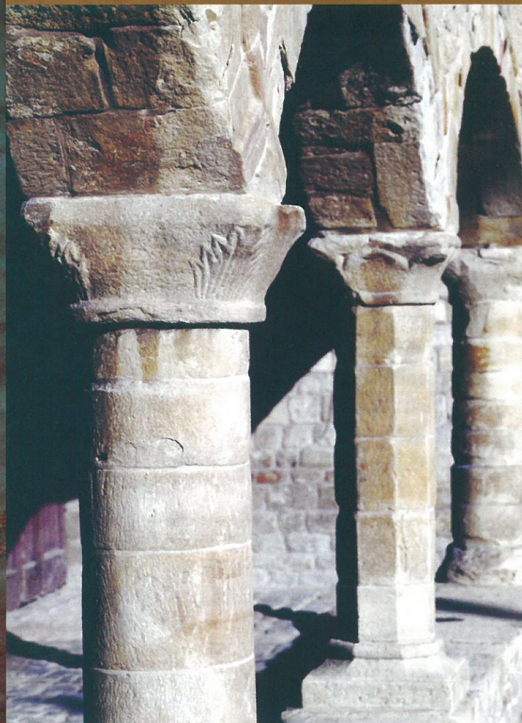
Particolare del loggiato inferiore dell'ospedale di San Paolo.
